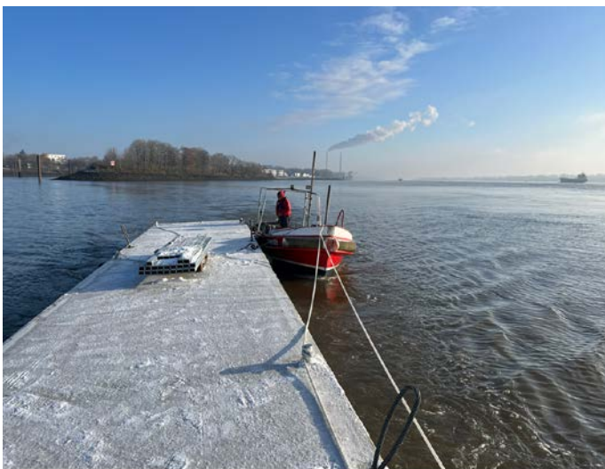
Betonschlengel auf der Elbe
